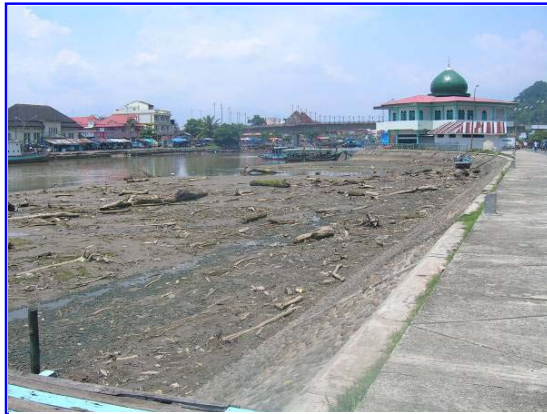
Gambar 2. 4. Endapan Sedimen di Sungai Batang Arau Sumber : Dinas Kimpiaswil Kota Padang, Januari 2007 Cat. Sekarang Sebagian sudah diangkat
