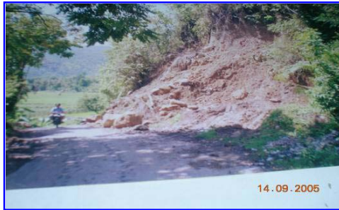
Gambar 2.1. Rawan Longsor di Bukit Koto Kaciak Sumber: Dinas Kesos & Penanggulangan Bencana, 2007
